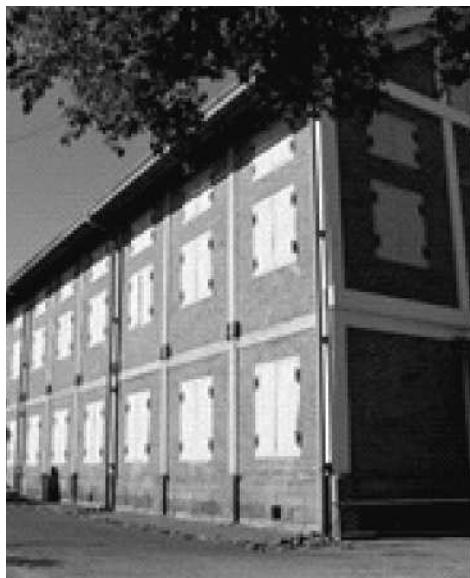
レンガづくりの富岡製糸場 (1872(明治5)年完成)
