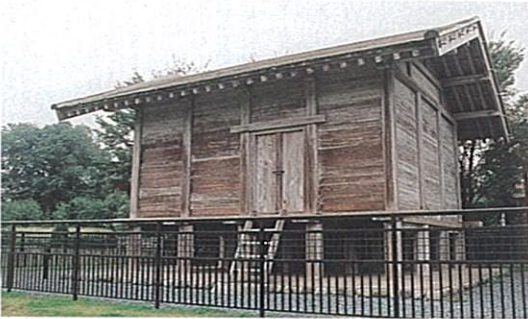
参考：岡部町中宿遺跡復元倉庫
