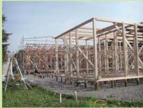
<仮設住宅の建設>
